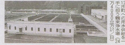
ろ過池の現場写真
