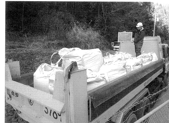
浄水場から搬出風景
